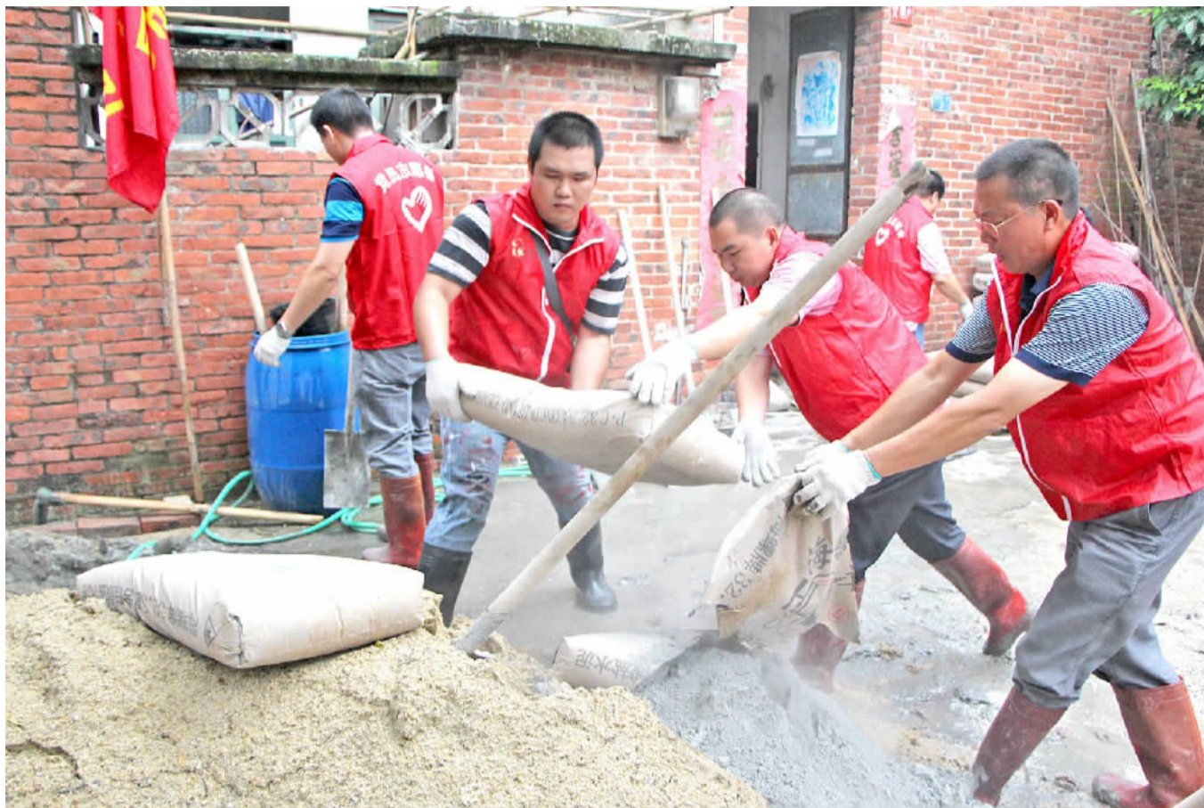
自2009年起，桂城党员志愿服务队开展旧房修葺行动，为困难家庭、独居长者等群体修葺翻新房子。
