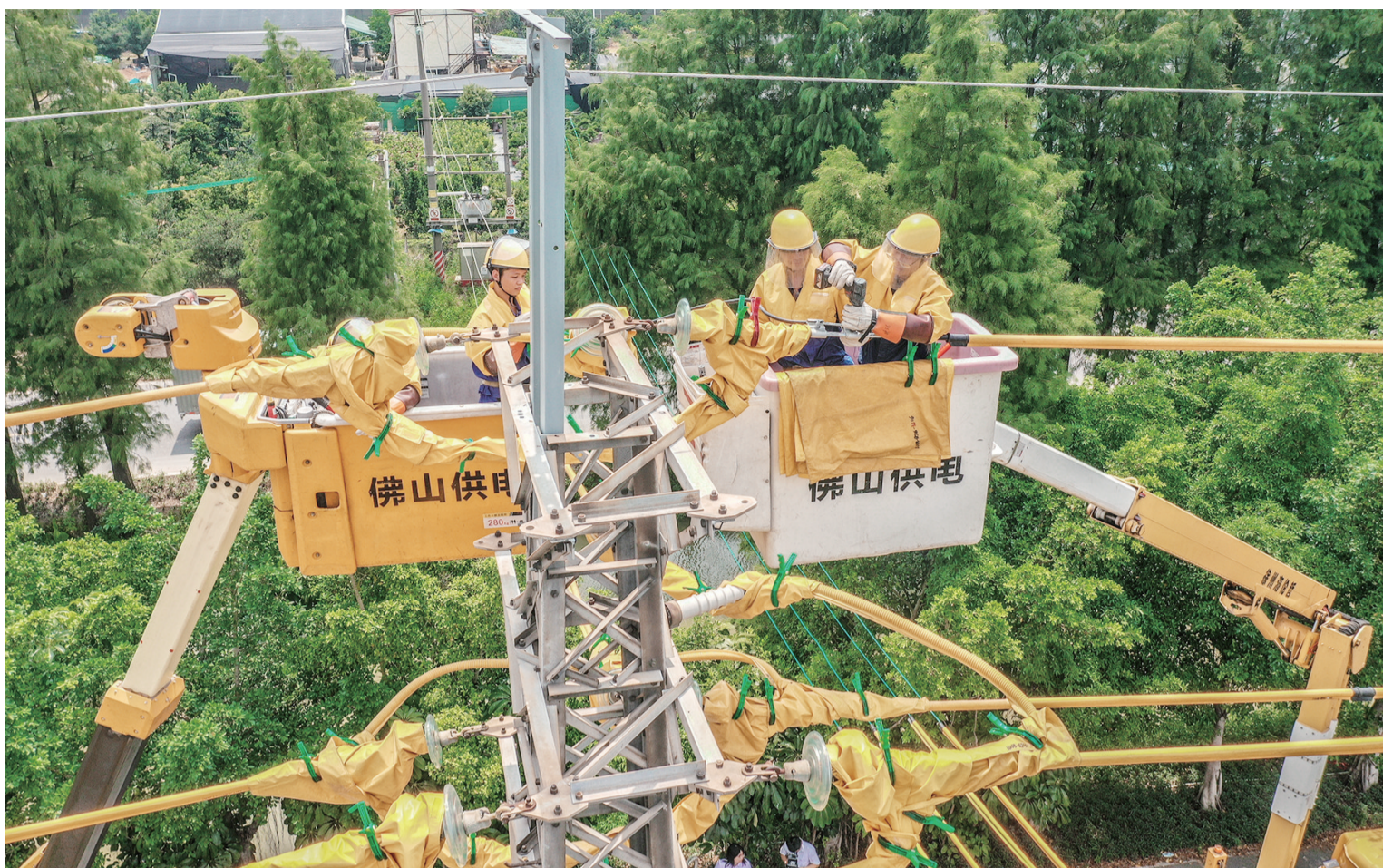
南海供电局通过带电作业提高供电可靠性，避免对用户生产生活造成不便。
