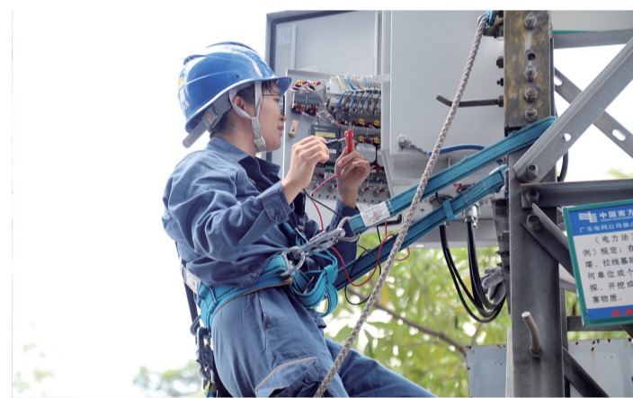
南海供电局工作人员在电力线路杆塔上检查设备。
