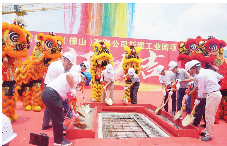
■总投资100亿元的信扬科技成像模组项目一期厂房工程主体结构在狮山顺利封顶。(资料图片)
