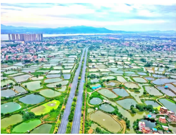
■九江镇内已完成改造的部分养殖鱼塘。 梁平 摄
