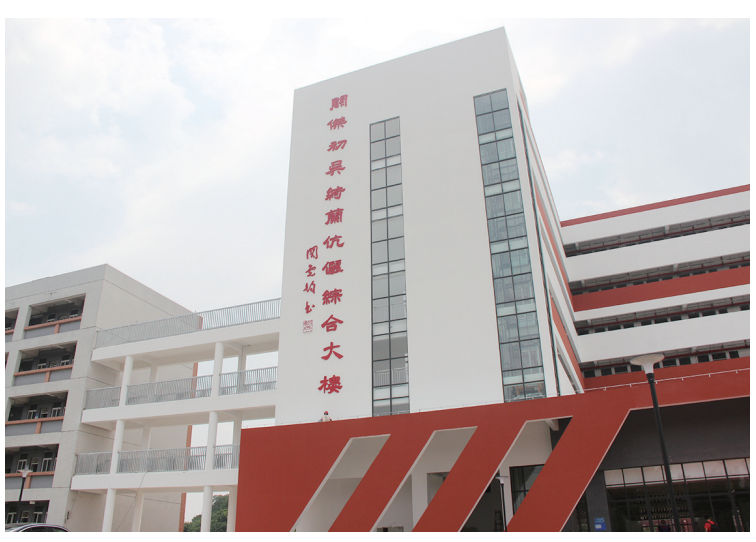
■新建宿舍楼即将交付使用。
