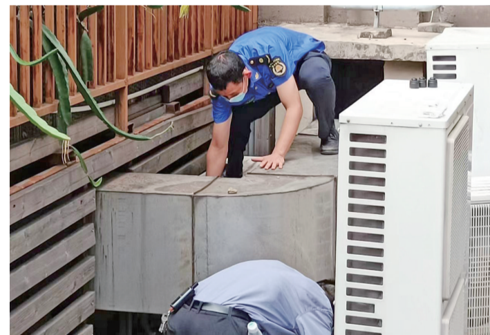
■执法人员检查油烟管道。
