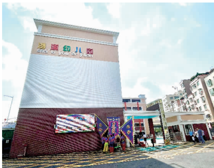
■重建后的沙溪幼儿园。
