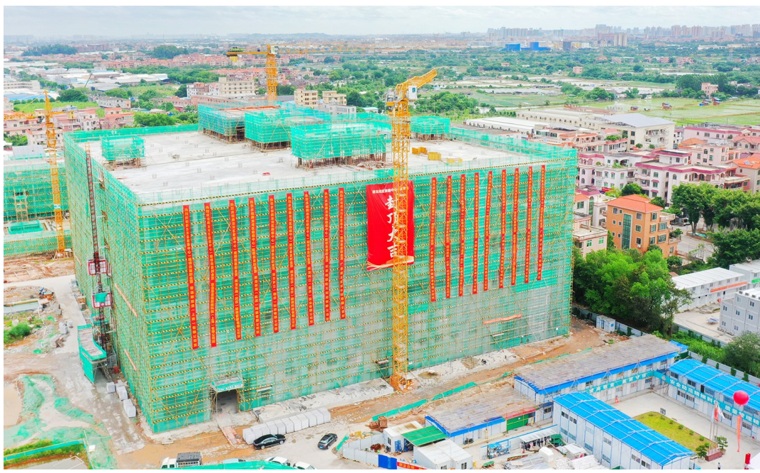
■腾龙湾区数据中心项目一期封顶。
