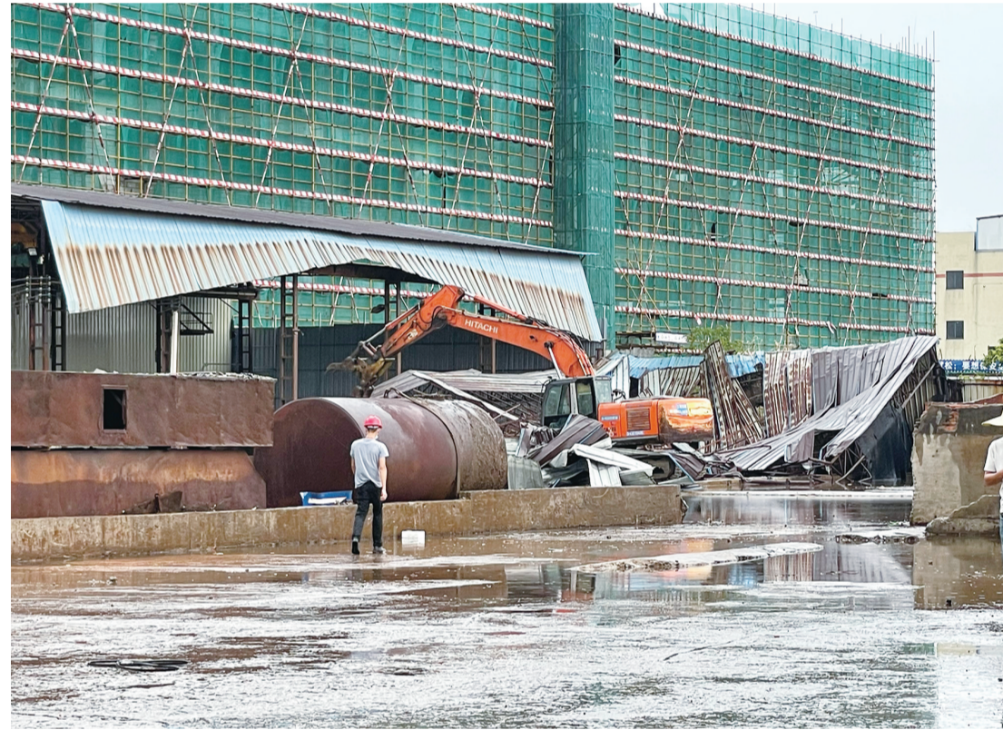
■对旧厂房进行拆除。
