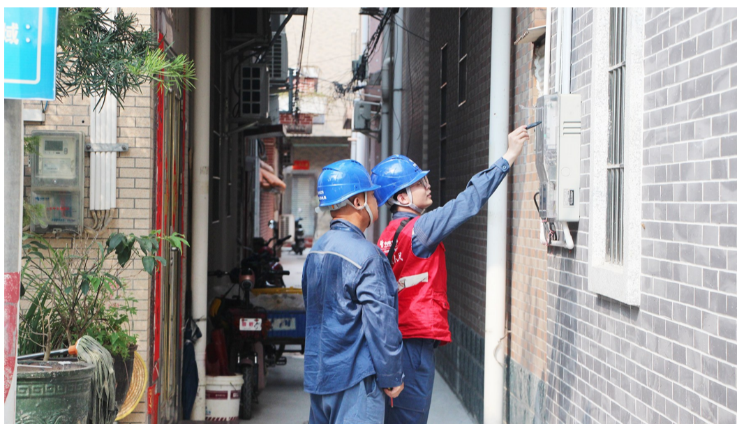
南海供电人在检查线路。
