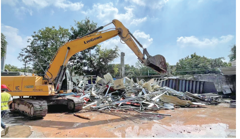
■执法人员现场对新增违建进行清拆。
