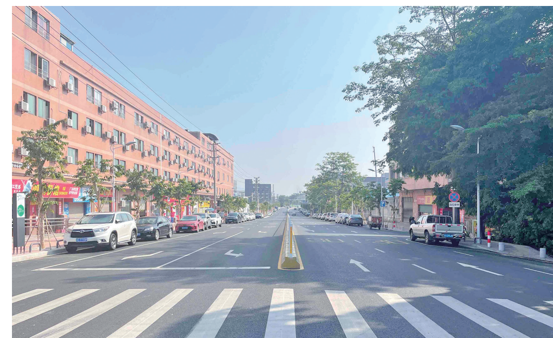
■璜矶大道(新堤西路-九江大道)经过改造后焕然一新,宽敞平坦。
