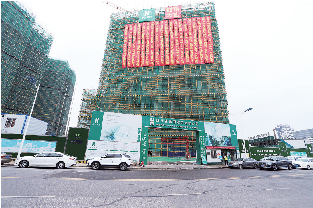
■ 中科安齿总部大楼已经封顶。
