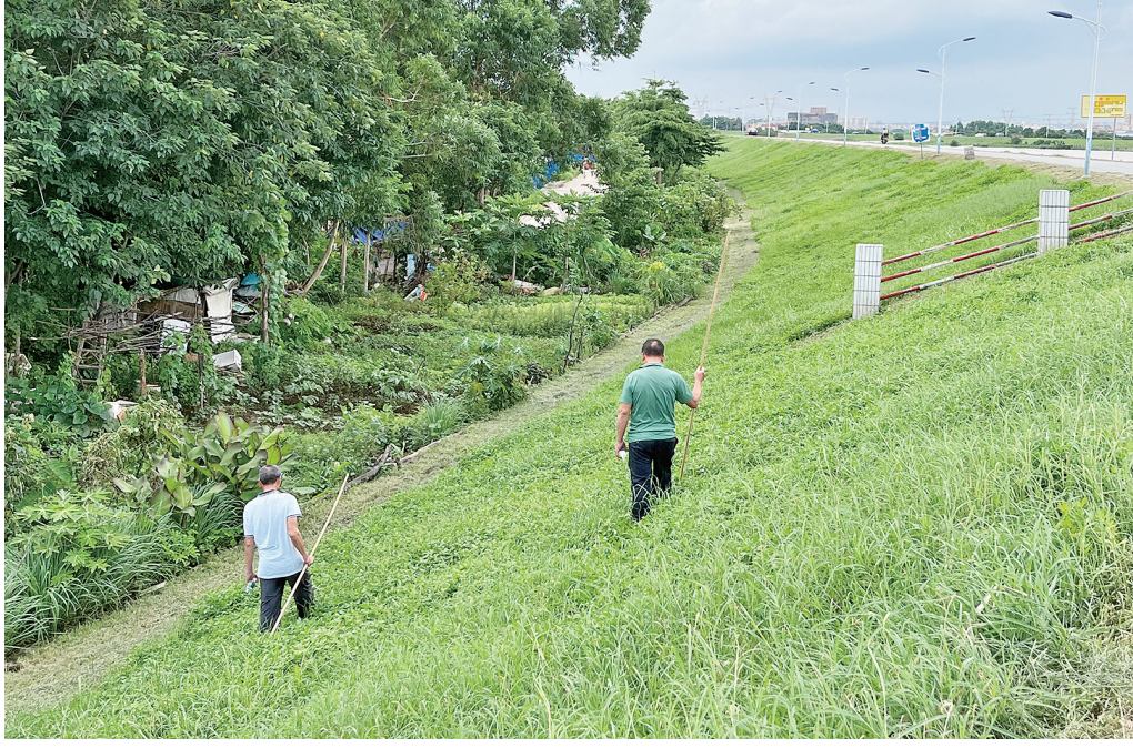
■丹灶镇村居工作人员检查堤围迎水和背水坡。
