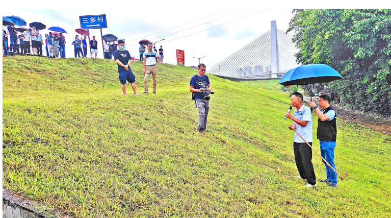
■巡堤查险队伍通过步行的方式对堤围进行全面细致的检查。
