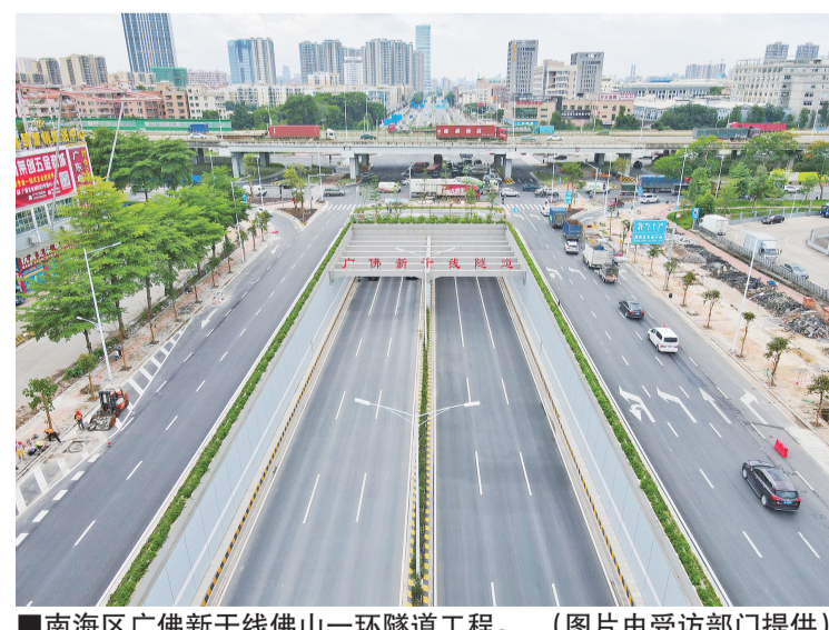
■南海区广佛新干线佛山一环隧道工程。(图片由受访部门提供)
