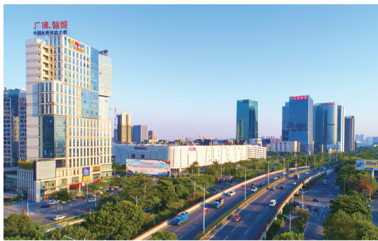
广佛国际商贸城已成为大沥电商产业园的核心区。 通讯员供图
