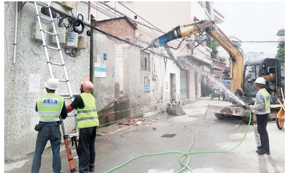
■“桂城战队”组织施工人员拆除违规搭建的公厕。
