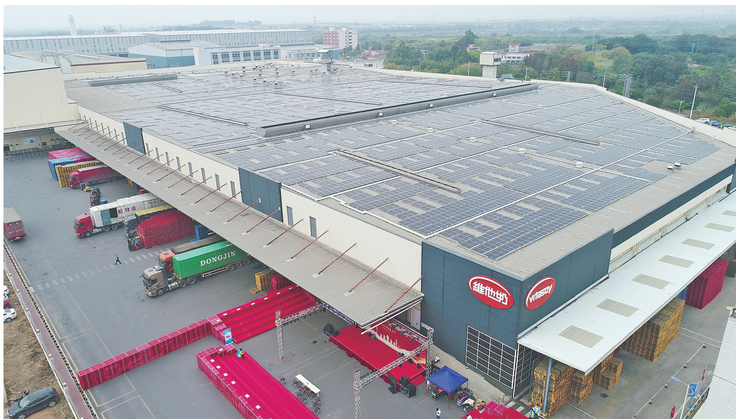
■维他奶佛山工厂光伏发电项目。
