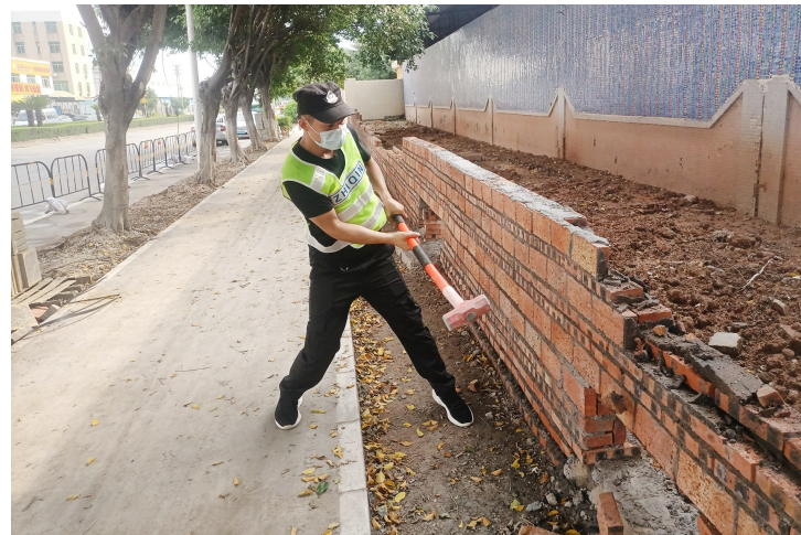
■工作人员用铁锤拆除路旁的违建墙体。
