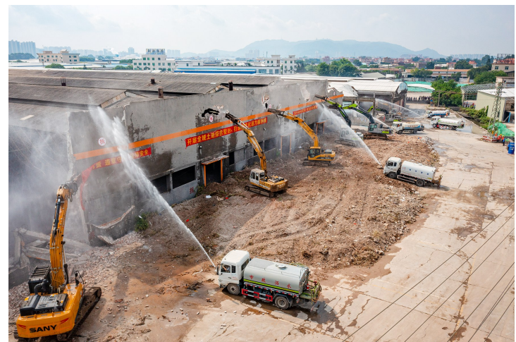
■西樵对三大千亩连片“工改工”项目之一的联创智慧产业园项目开展集中拆除。
