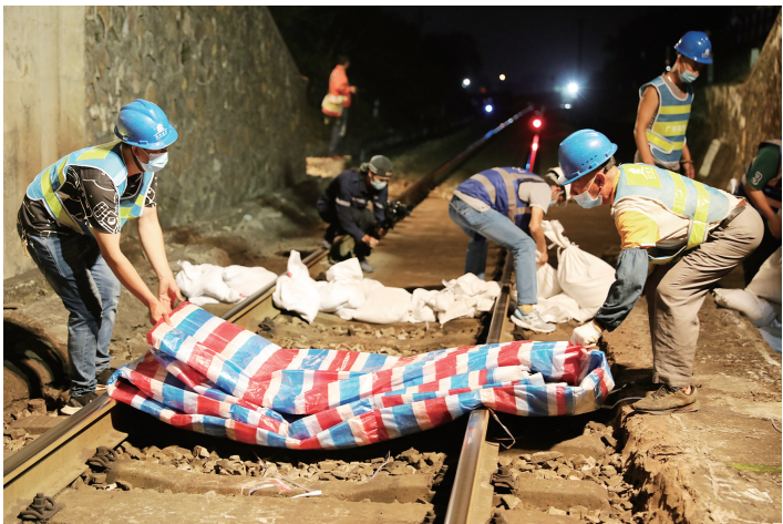
■抢险人员拿出彩条布准备罩在钢闸门上。
