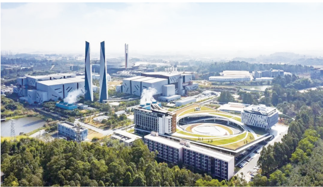
■瀚蓝南海固废处理环保产业园。
