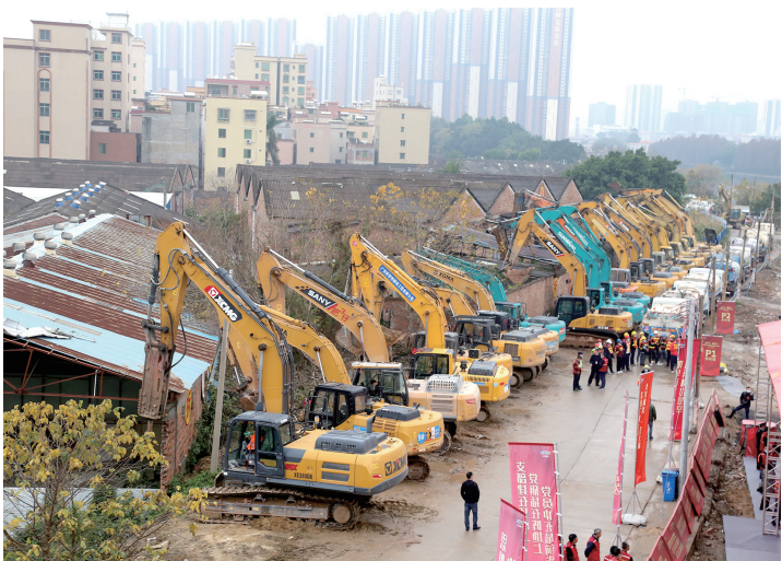
■大沥镇泌冲大沙工业区改造项目集中拆除现场。 珠江时报记者/黄晴雯 摄
