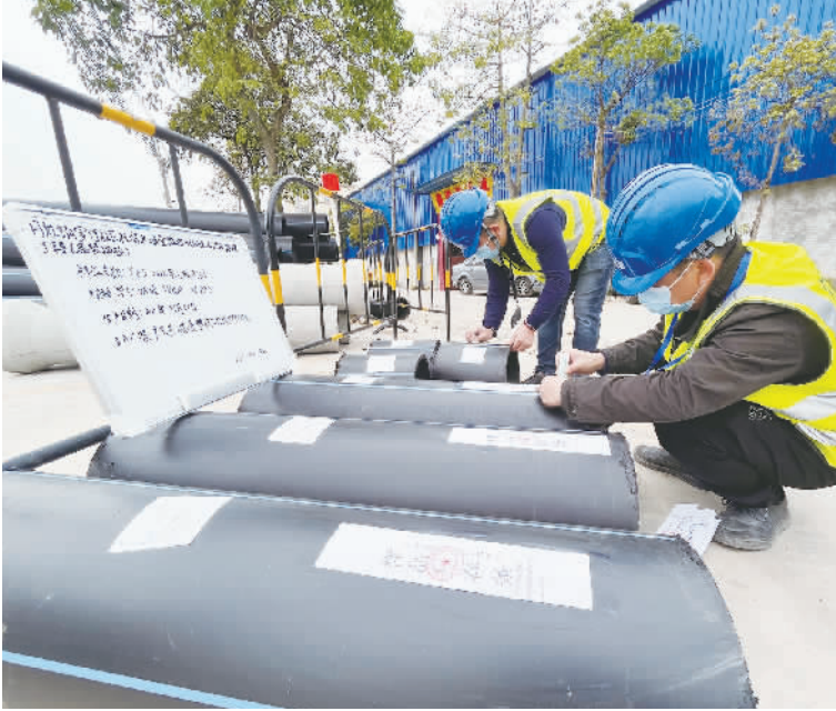
■工作人员对农村生活污水治理工程建筑材料进行抽检。
