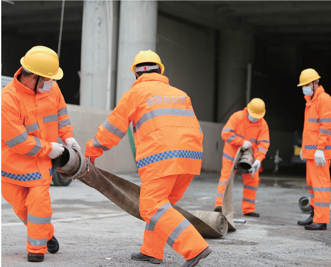
■桂城市政办派出应急排涝队协助排涝抢险。
