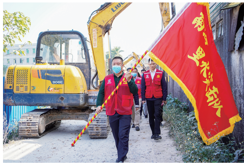
■里水突击队开展里湖新城及南海区有轨电车里水示范段项目拆除行动。
