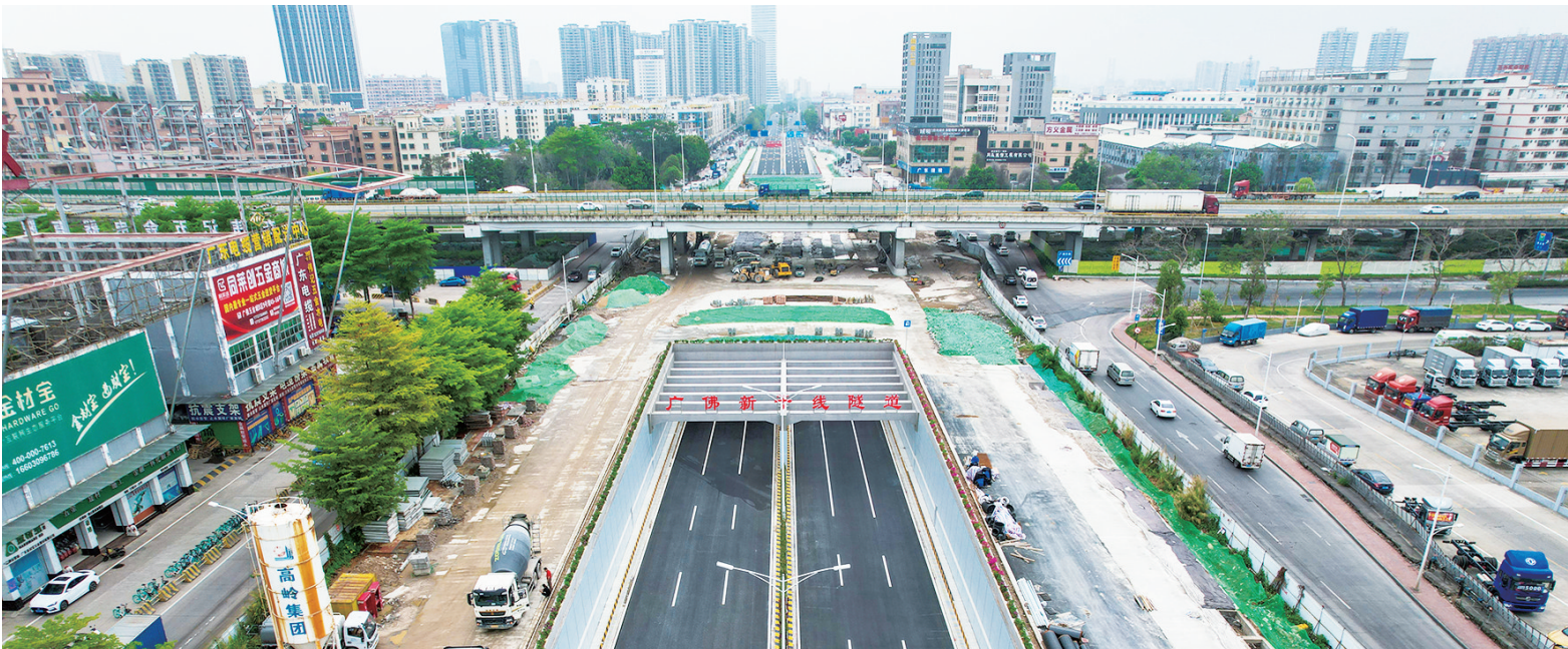
■广佛新干线佛山一环隧道工程主线建成通车,往返广佛更加便利。 珠江时报记者/黄永程 摄
