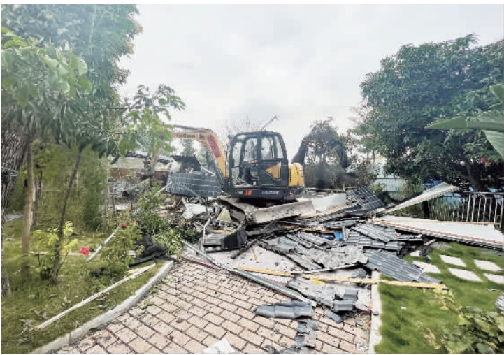
■出动挖掘机,对板房、棚架进行拆除,并清拆硬底化地面。
