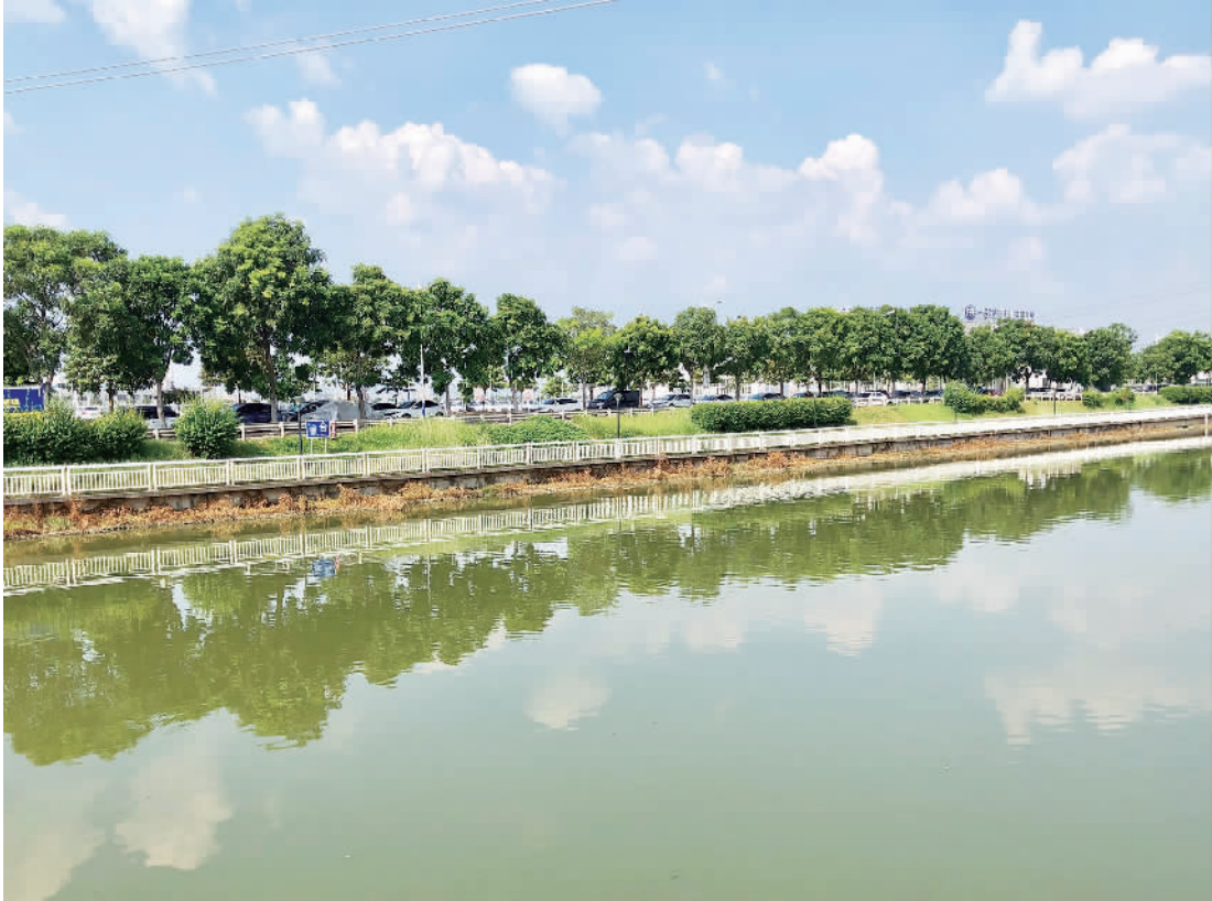
■狮山镇城建和水利办全力推进排水单元截污,多措并举提升治水效能。
