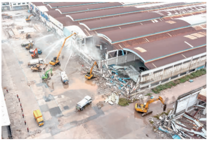
■西樵镇三大千亩连片“工改工”项目之一的山南产业社区项目启动拆除。通讯员供图
