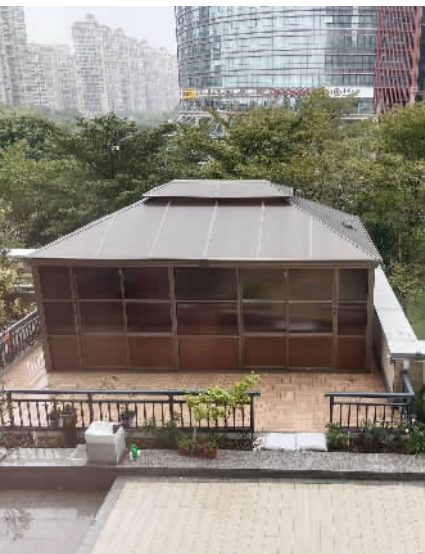
■违建玻璃房拆除前。
