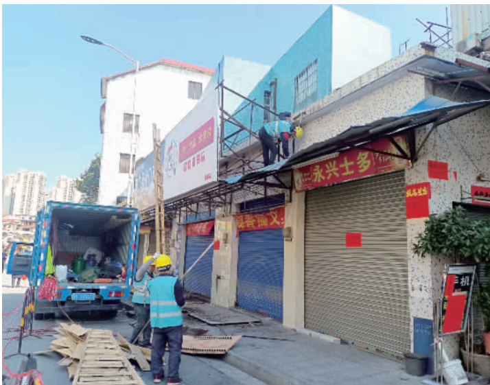
■施工队拆除商铺违规设置的广告牌。
