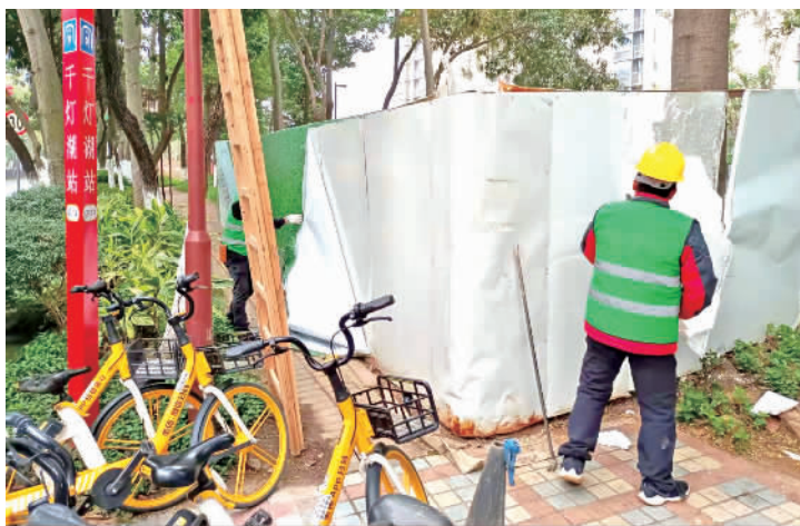
■施工队对违规围挡进行治理。
