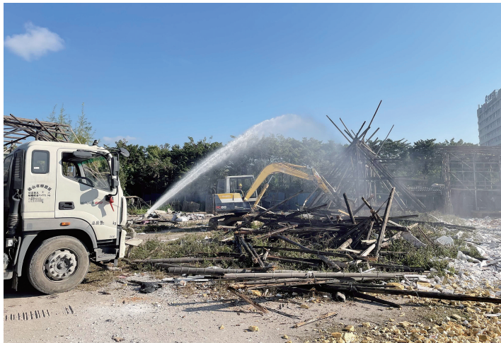
■拆违现场。(通讯员供图)
