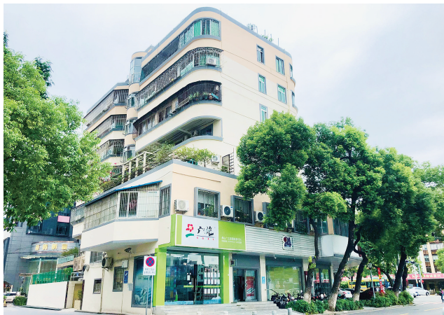
■南海大道沿线建筑外立面改造工程已完工。（资料图片）
