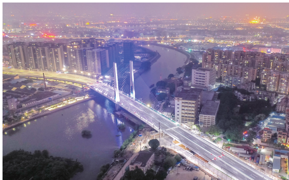
■海五路西延线(南海段)。 珠江时报记者/廖明璨 方智恒 摄
