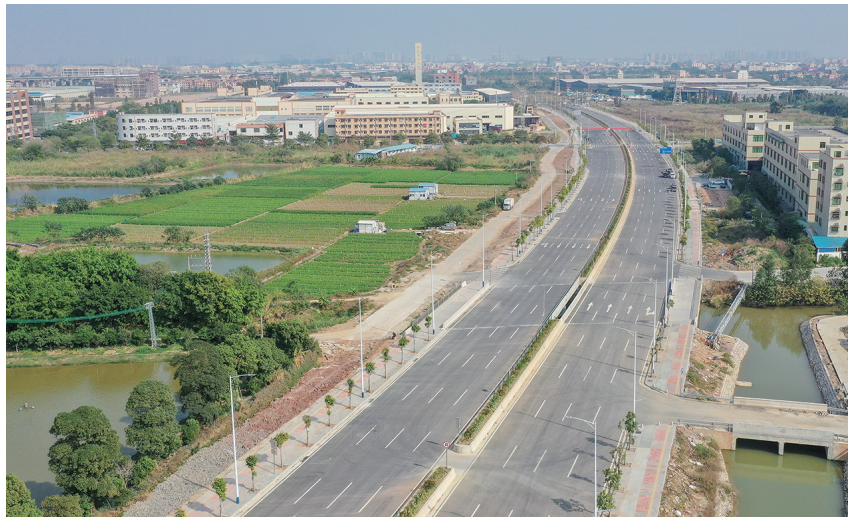
■粤桂黔高铁经济带合作试验区(广东园)中线公路工程博爱路段二期工程。 珠江时报记者/廖明璨 摄
