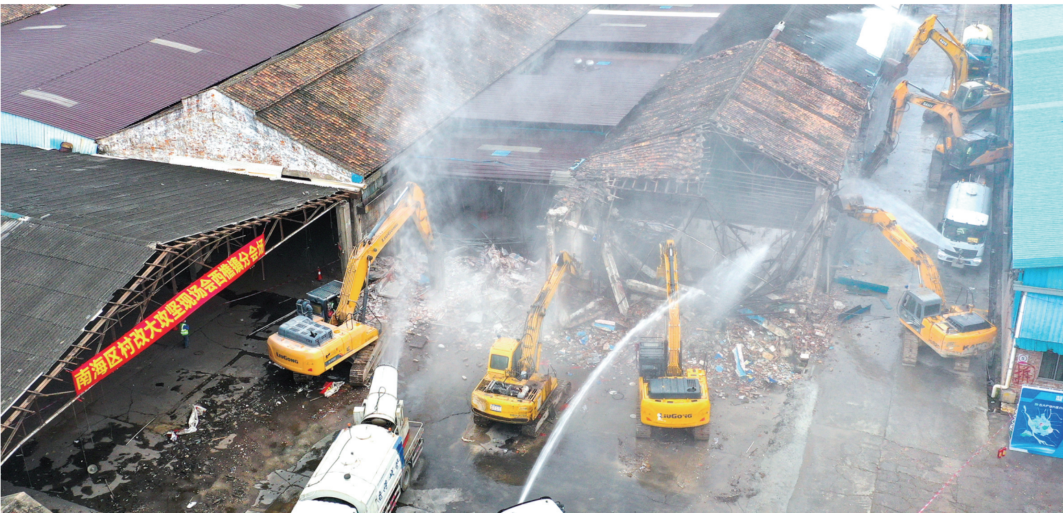
■南海村改大攻坚现场会西樵镇分会场拆除现场。
