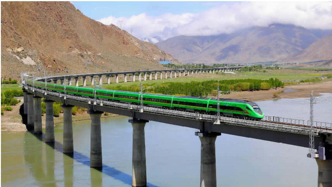
■试运行的复兴号列车行驶在桑日县境内。
