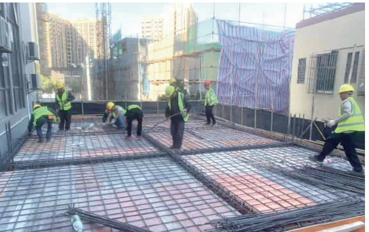
■施工队伍在拆除违建。(通讯员供图)
