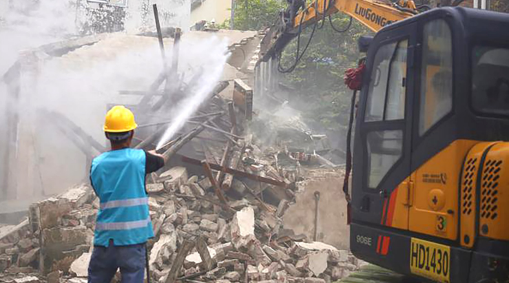
■拆违现场。(通讯员供图)
