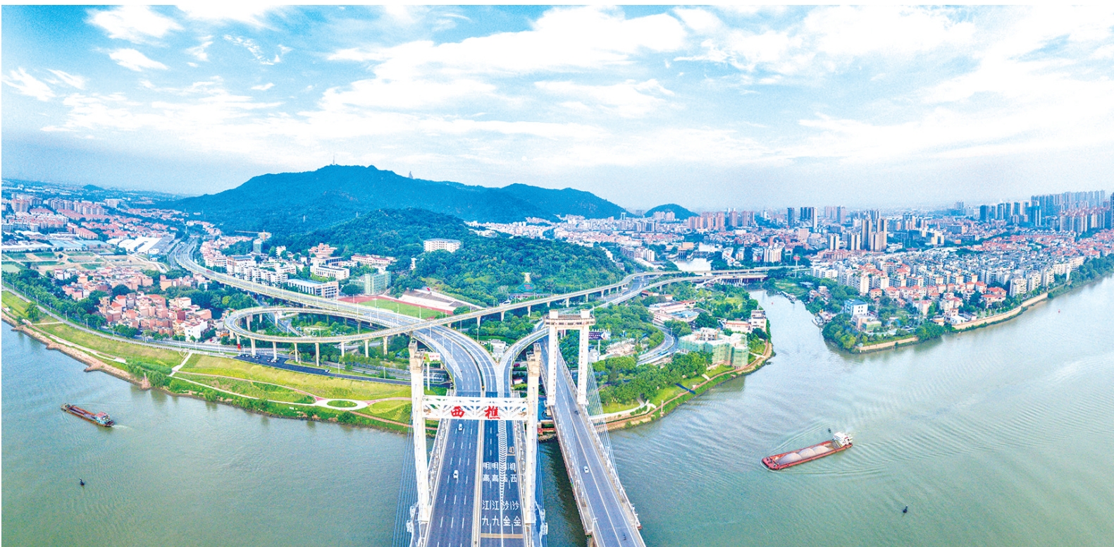
■西樵镇在党建引领下,迈出高质量发展的步伐。图为西樵大桥。
