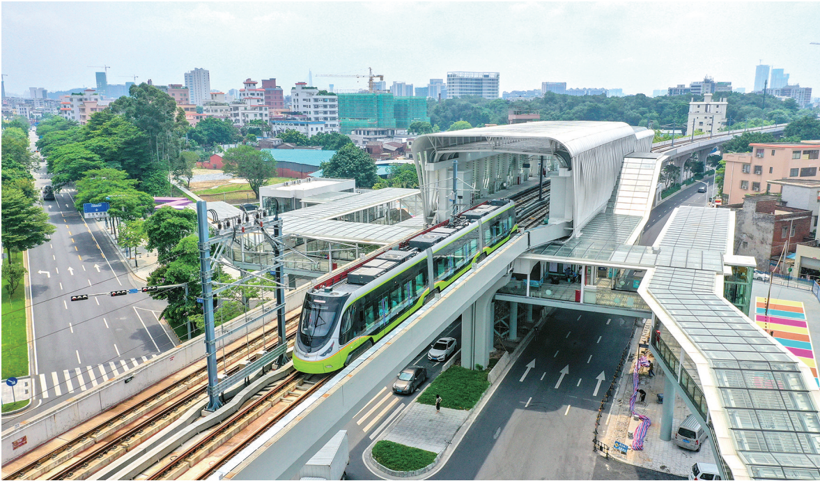
■8月18日,南海有轨电车一号线首通段正式运行。
