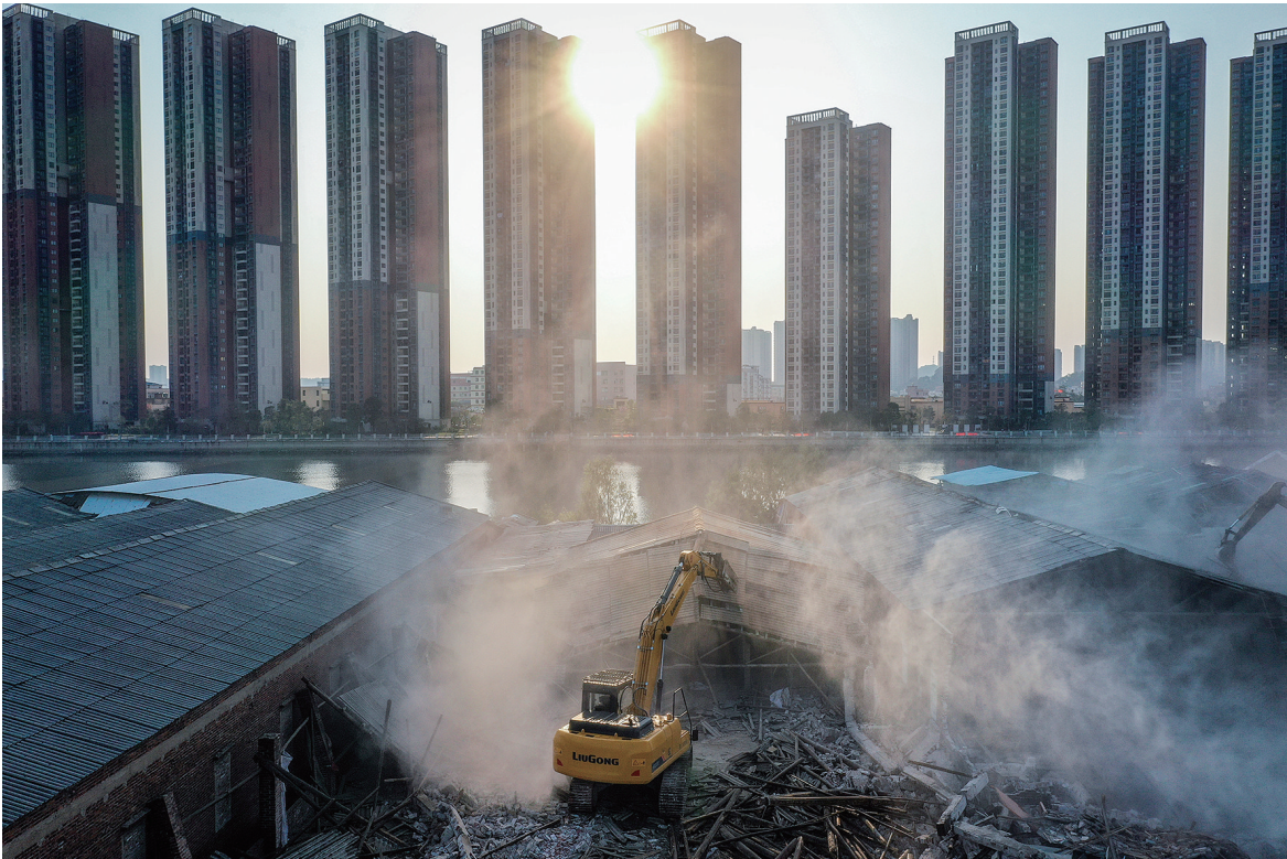
■南海持续推进村级工业园的大拆除、大建设、大整治。图为大沥镇大沙工业区清拆现场。珠江时报记者/方智恒 摄
