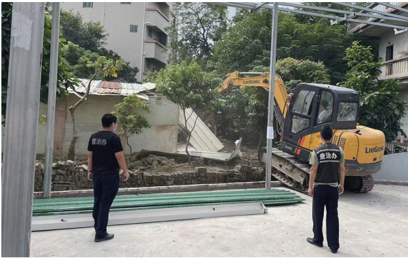
■钩机出动拆除铁皮屋。
