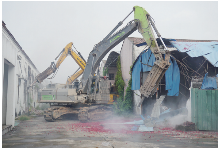
■四台大型吊机同时启动作业。
