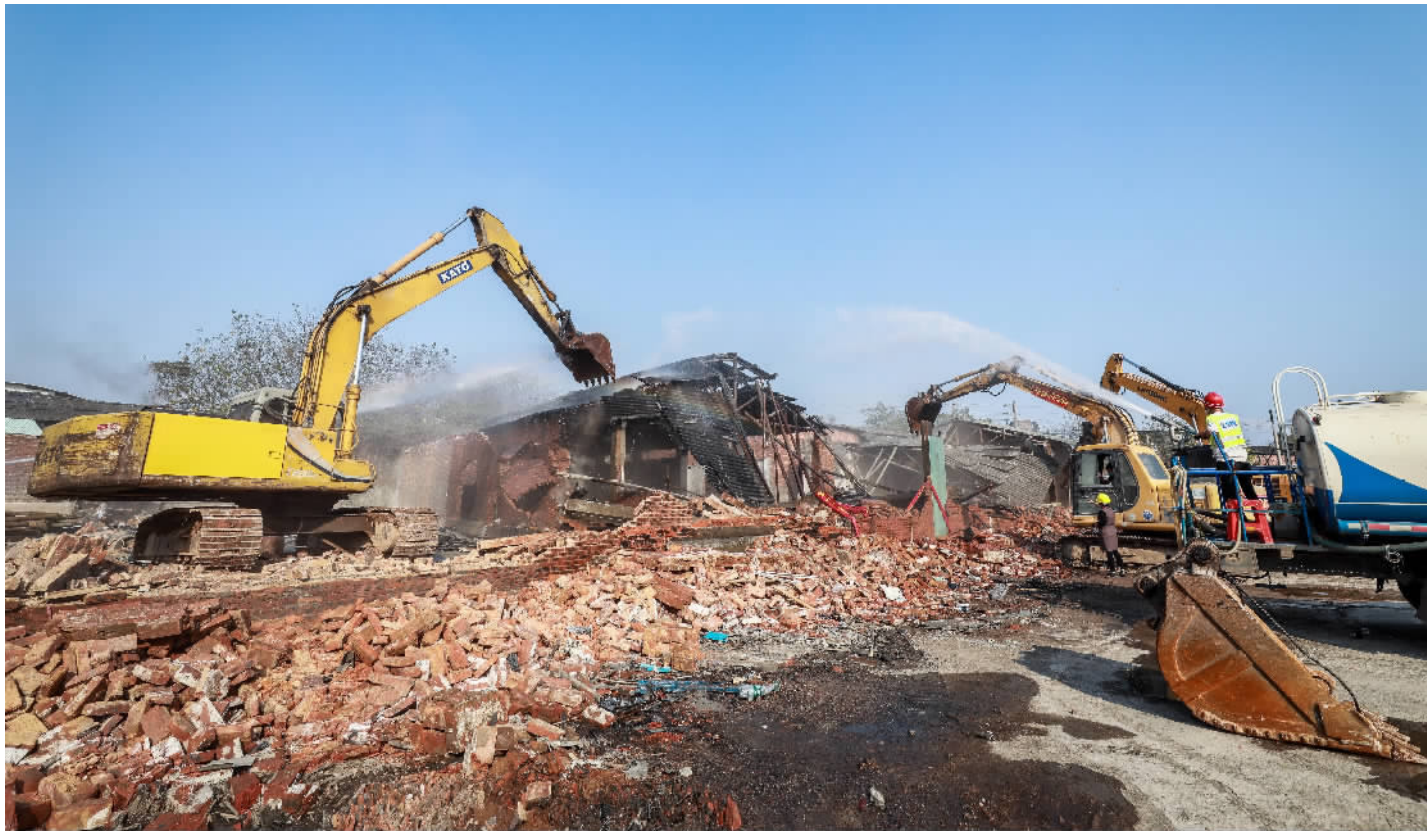
■狮山镇村级工业园连片改造项目拆除现场。
