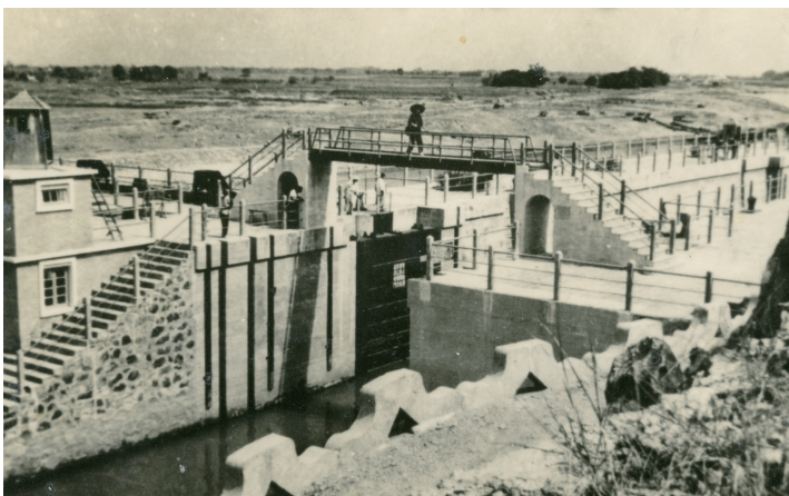
■1953年竣工的樵北大围联围主要工程——官山大闸。
