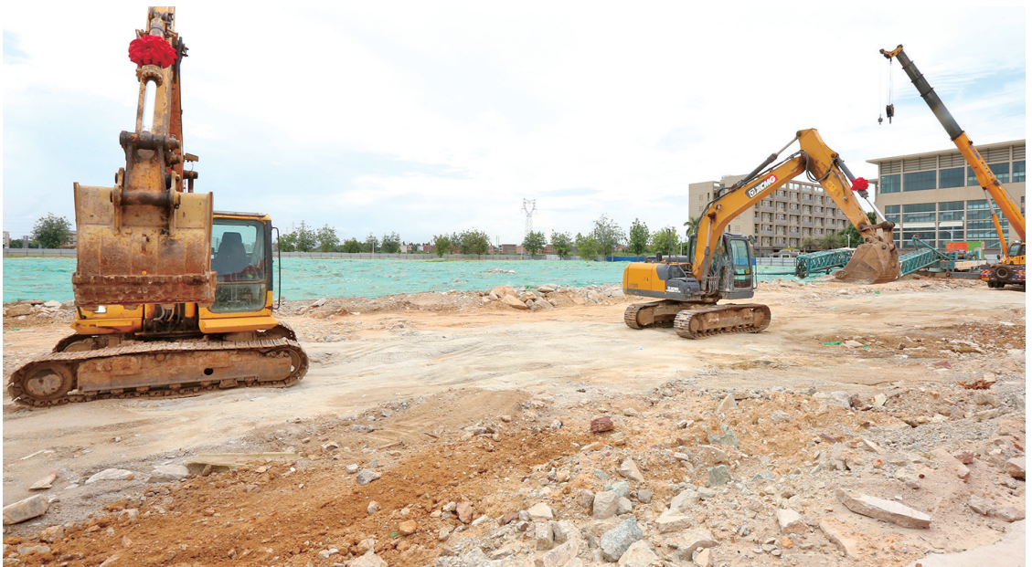
■项目所在地块已基本平整完毕。
