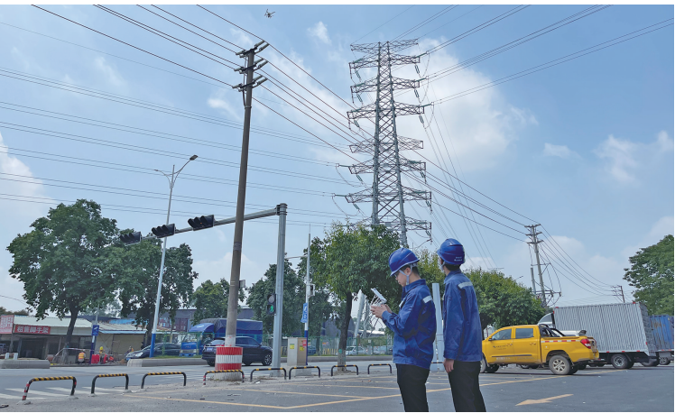
■南海供电局工作人员使用无人机进行巡检作业。
