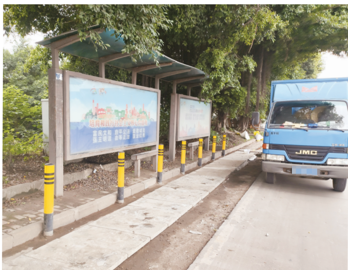
■目前该公交站前损坏的水泥盖板已更换完毕,安全隐患得以消除。通讯员供图
