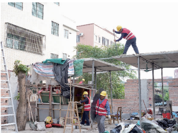
■桂城街道查治办组织施工队拆除违建物。(通讯员供图)
